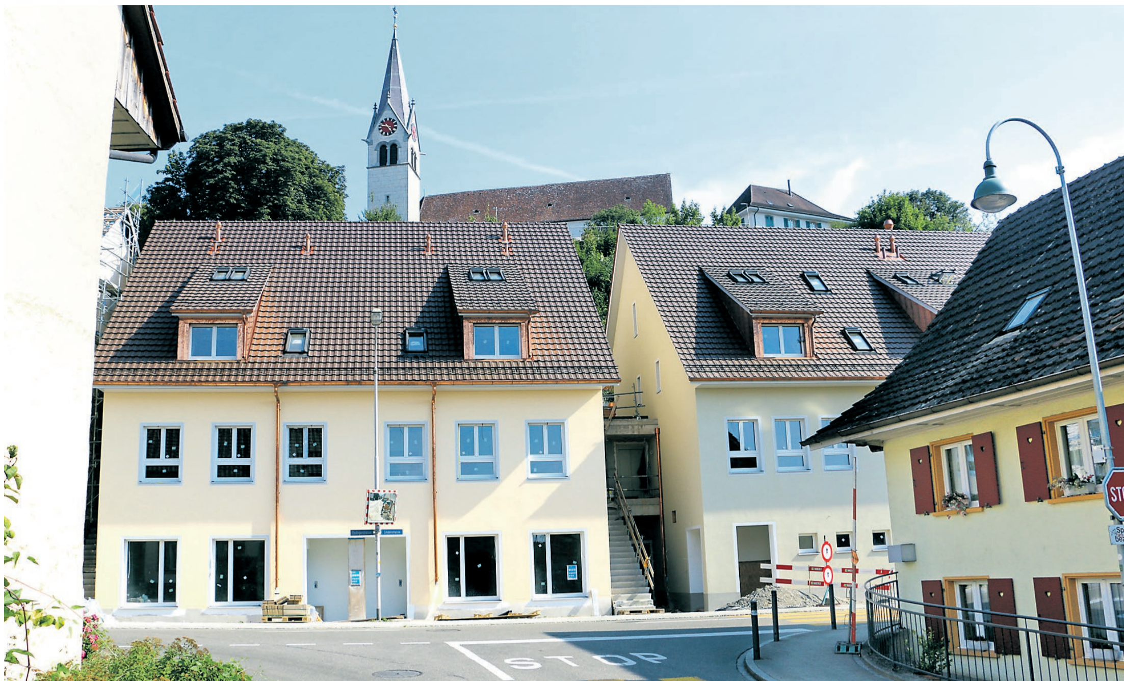
Die Häuser C und D von der Dorfstrasse aus gesehen.
