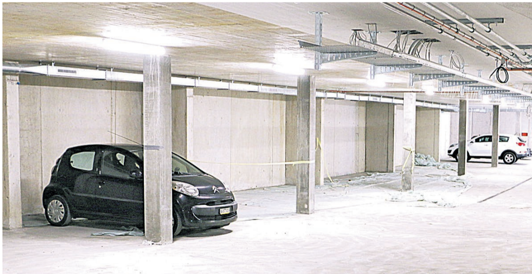
Die Tiefgarage mit 25 Parkplätzen.
